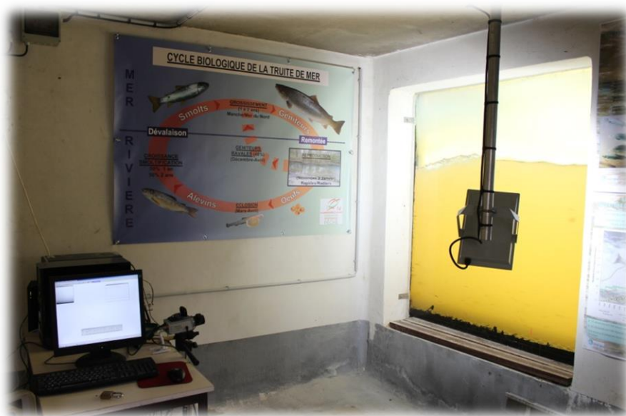
Figure 4 : Dispositif de vidéocomptage de la station du Breuil-en-Auge
