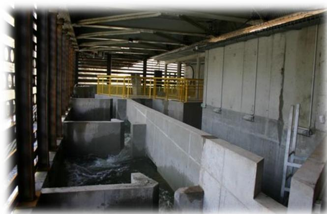
**Figure 3 : Passe à bassins successifs du barrage du Breuil-en-Auge**
